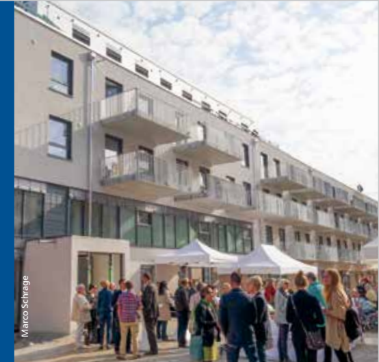
Rund 100 Gäste feierten die Eröffnung des Generationenhauses in der Nürnberger Neubleiche.
